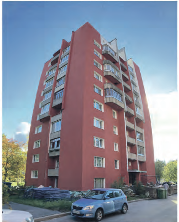
Сосновый Бор. Завершение капремонта на ул. Героев, 11
